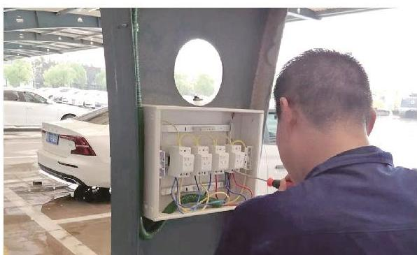
随着学院教职工新能源汽车数量逐渐增加，校内配套的充电设施日趋紧张，近日，后勤保障部根据教师需求，安排专人确认新能源汽车充电桩装置点位置，测算出新能源汽车用电功率，组织电工加班重新铺设线路，圆满完成了8处新能源汽车公共充电装置增装工作，有效满足广大教职工新能源汽车的充电需求，确保“平安校园”建设平稳有序。
